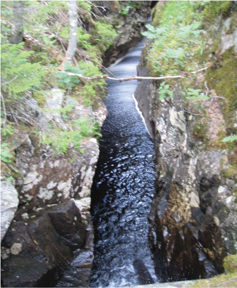
I vestre ende av Bjørvannet ble det på 1780-tallet sprengt ut et nytt, kunstig løp, slik at vannet ble en del av Hoensvassdraget.
