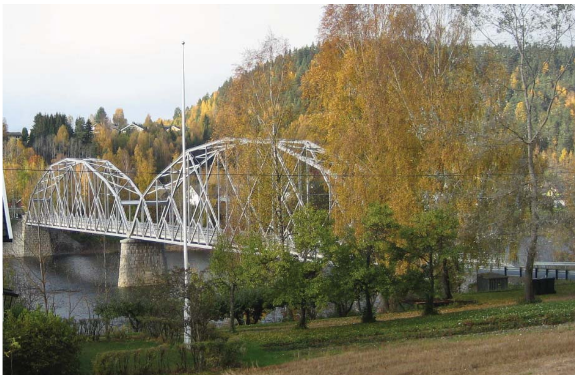
Skotselv bru sto ferdig i 1928. FOTO: BENT EK
