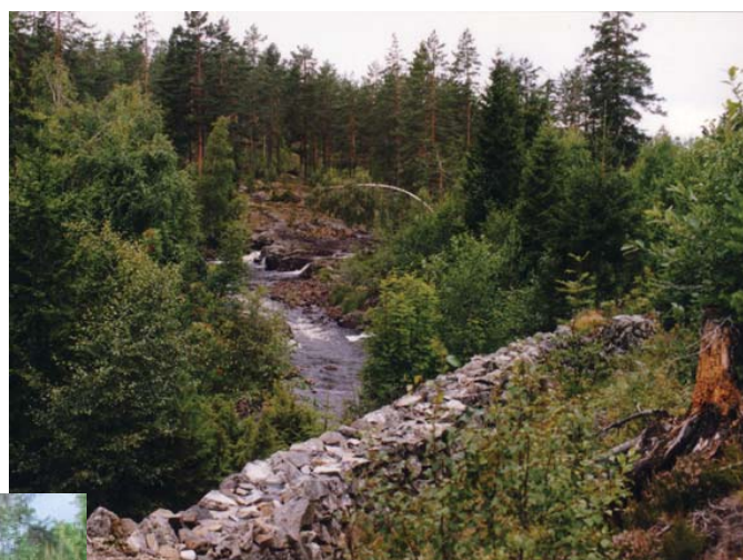
Vannrenna ved Pukkverket. FOTO: JOSEF E. HANSEN
