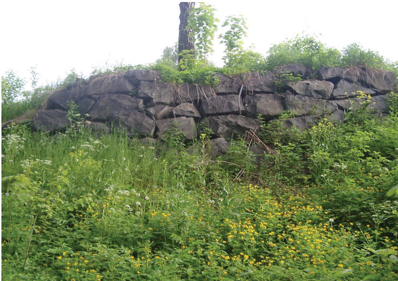
Fundamentet til «Stormølla». Hoenselva har vært et sentrum for bergverksdrift helt fra middelalderen og fram til vår egen tid.
