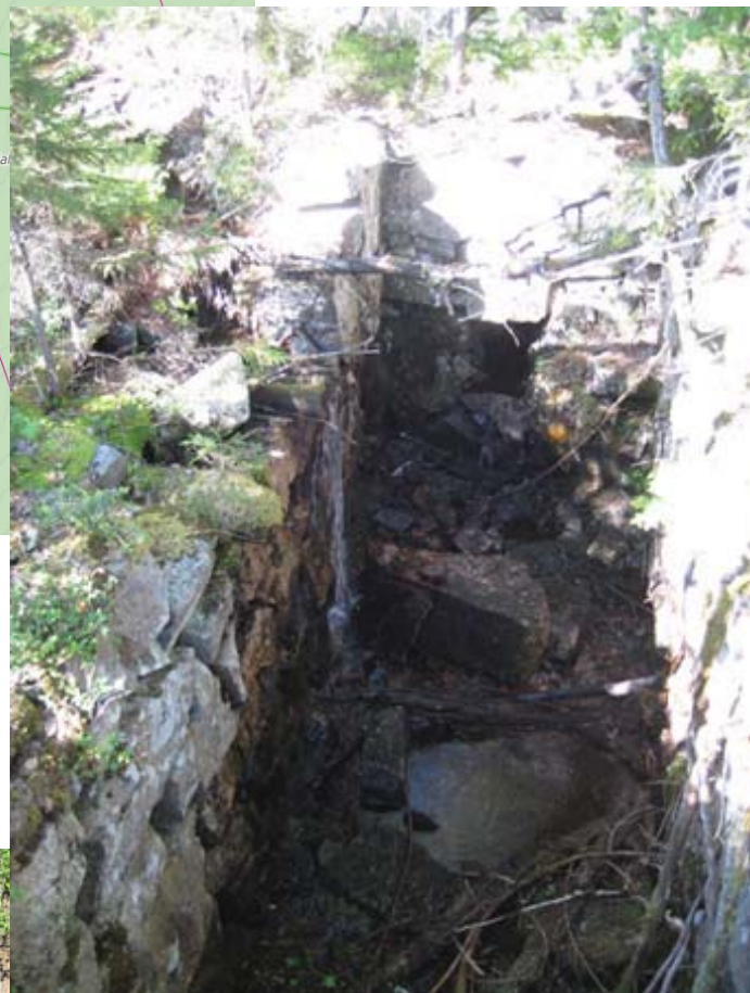
Fundament for hjulhuset, der det sto et vannhjul som ble drevet med vann fra ei kunstig renne.
