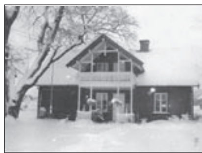
Etter restaurering og mange timers arbeid fremstår huset slik. (foto: Henriksen)
