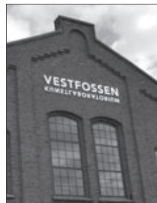
Anonym og smakfull skilting som passer til bygget.
