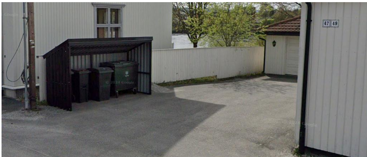
Foto 2 Ubrennbar skur for plassering av avfallsdunker er et godt tiltak (Google Maps).
